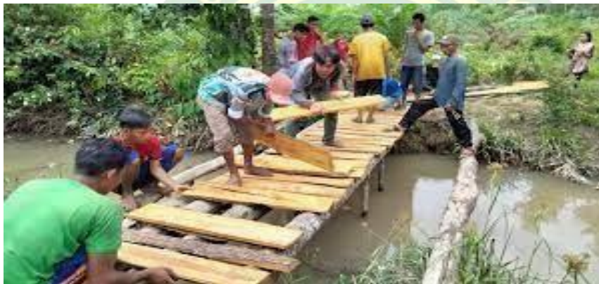
Warga bergotong royong membangun jembatan
